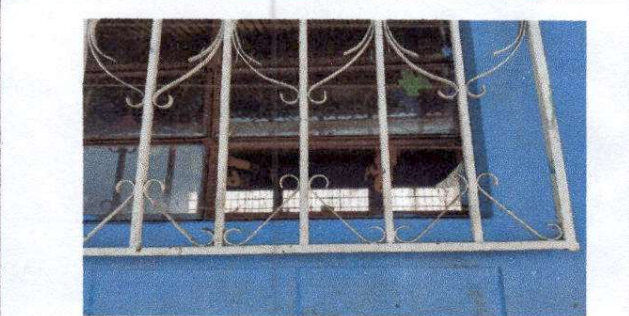
Foto 6: Sustitución de vidrios.
