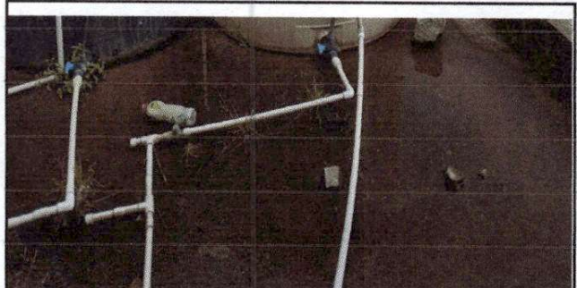
Foto 12: Sustrucción de accesorios deposito de agua.
