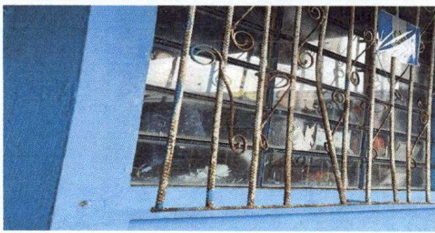
Foto 7: Sustrucción de balcones.
