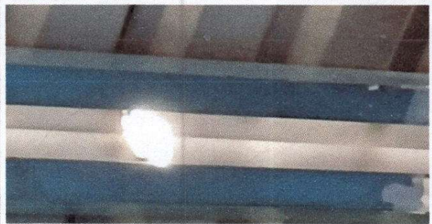
Foto 2: Sustitución de capote para lamina troquelada.
