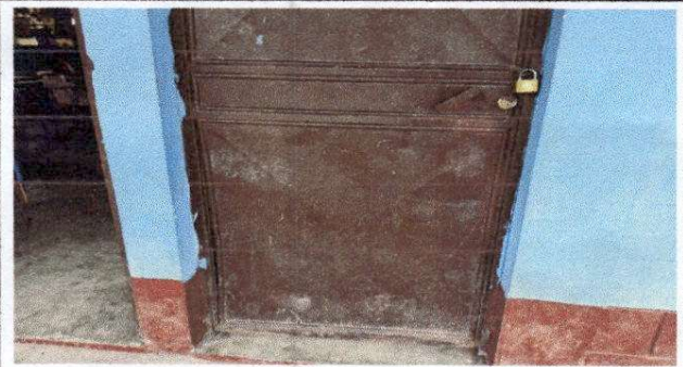
Foto 4: Mantenimiento a estructura (lijado, cambio de tubo, cepillado, sujeciones).
