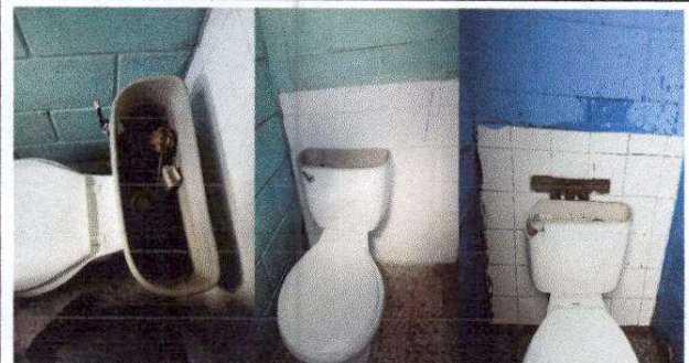
Foto 10: Sustrucción de inodoro.
