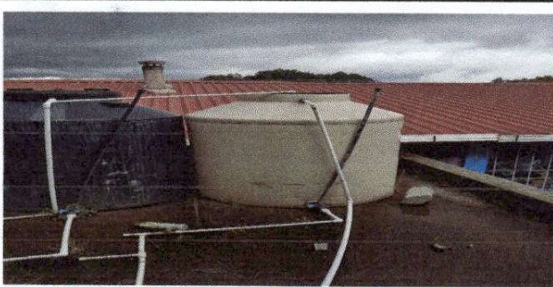
Foto 11: Sustrucción de deposito de agua 1700 LT.
