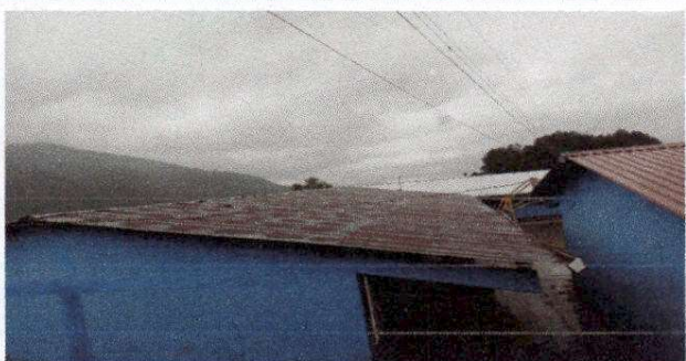
Foto 1: Sustitución de lámina, por lamina troquelada aluzinc calibre 26.
