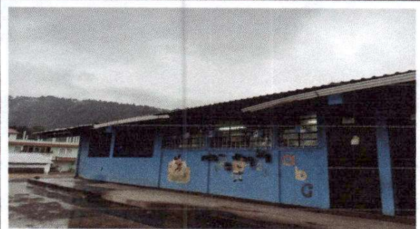
Foto 8: sustitución de canale pvc.
