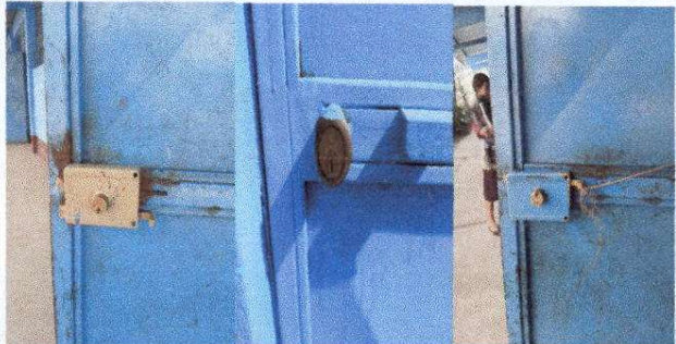
Foto 5: Sustitución de chapas.
